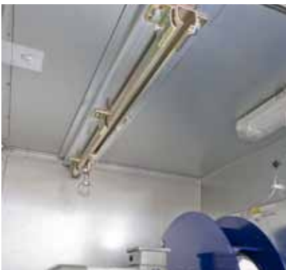
Uittrekrails voor het vervangen van de ventilator
