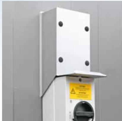
weerbestendige afdekking werkschakelaar
