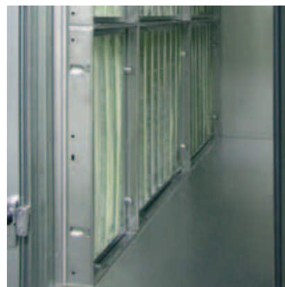
Filterframe vast ingebouwd
