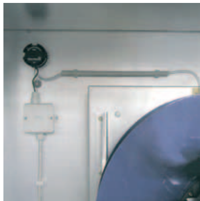
Volumestroommeting bij de ventilator
